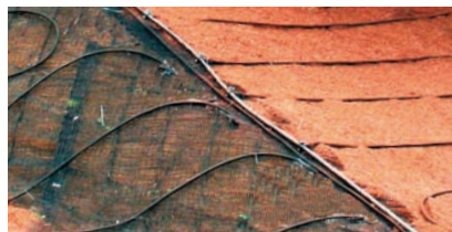
Armatura con georeti e tubi di subirrigazione
