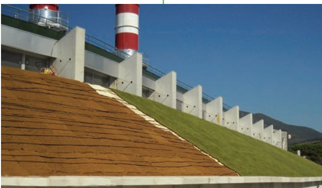
Posa su copertura inclinata con tappeto erboso in rotoli steso su feltro di livellamento in materiale sintetico
